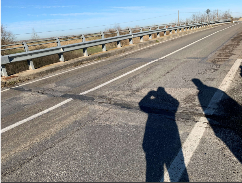
9. PONTE SP 115 PK 1+954 (Conselice)
