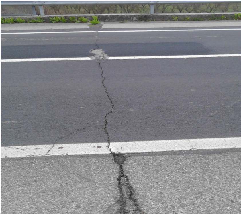
7. PONTE SP 33 PK 0+530 (Ravenna)
