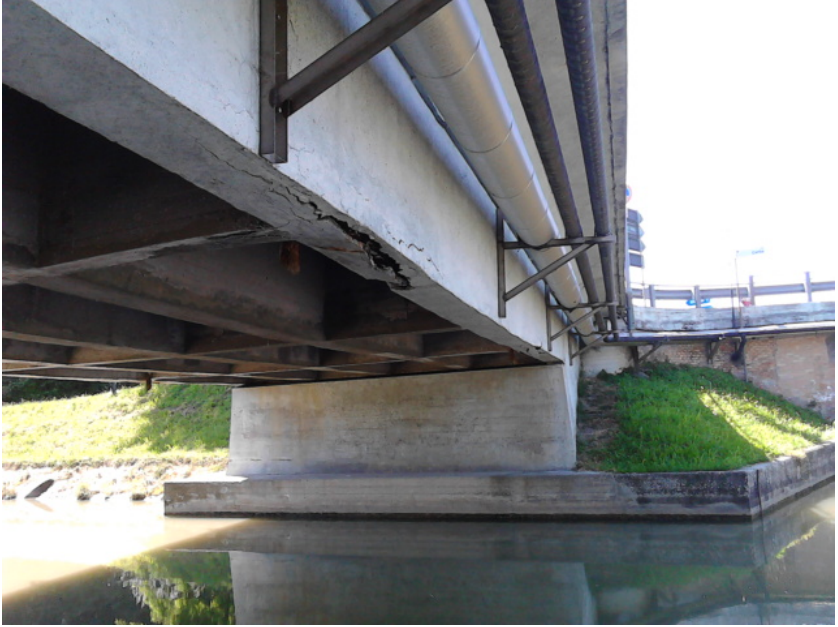
10. PONTE SP 1 PK 3+575 (S. Alberto-RA)
