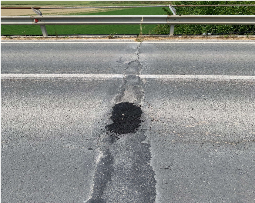
8. PONTE SP 101 PK 4+866 (Ravenna)
