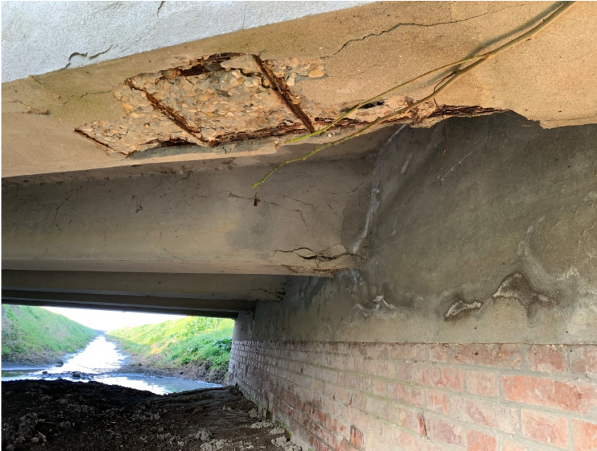
2. PONTE SP 99 PK 4+890 (Ravenna)
